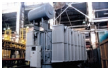
Производственный комплекс трансформаторов
