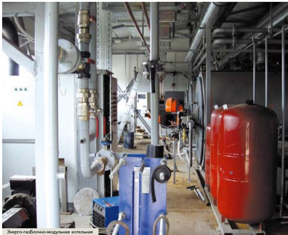
Энерго-газБлочно-модульная котельная
