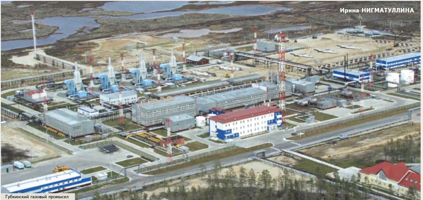
Губкинский газовый промысел
