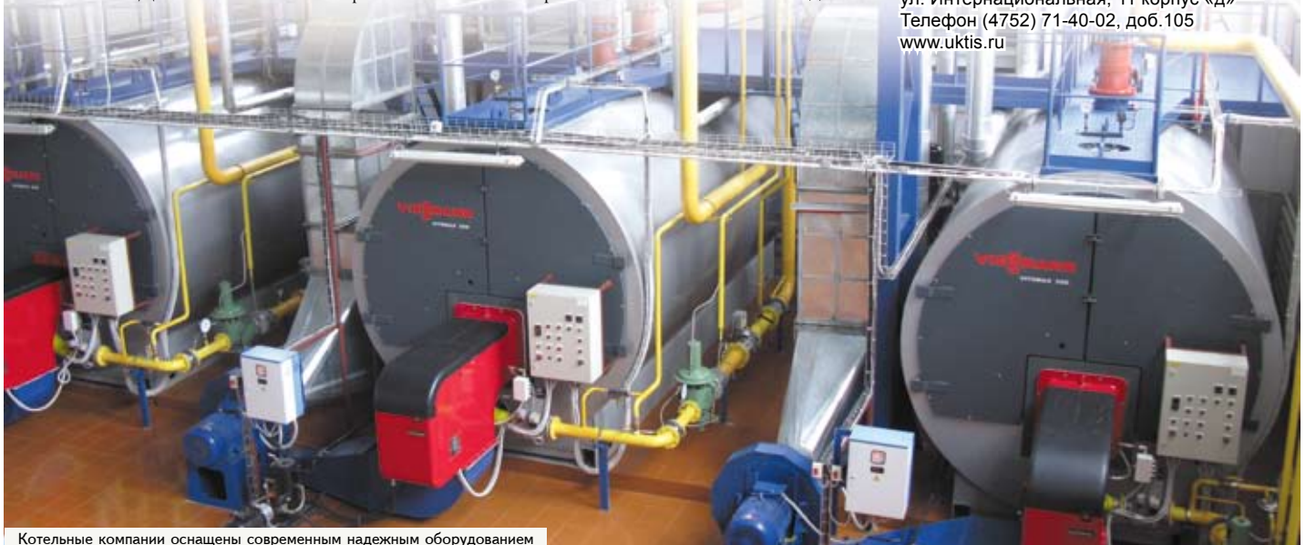
Котельные компании оснащены современным надежным оборудованием
