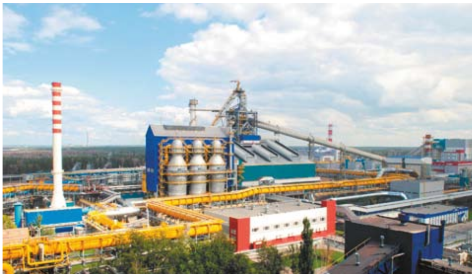
Комплекс доменной печи «Россиянка»
