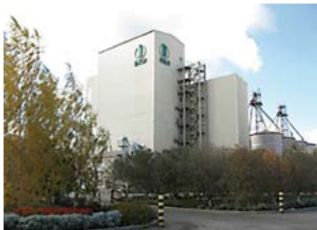
Здание комбикормового завода
