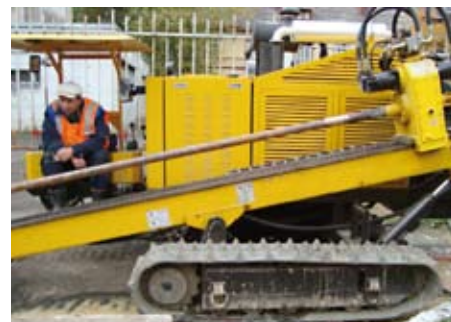
Установка горизонтально направленного бурения
