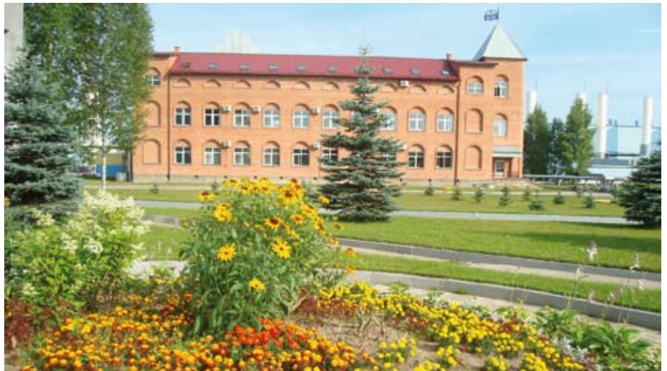
Здание диспетчерского пункта Нюксенского линейно - производственного управления магистральных газопроводов
