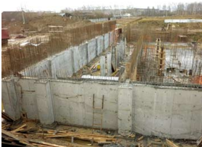
Строительство 4-го блока очистных сооружений водопровода
