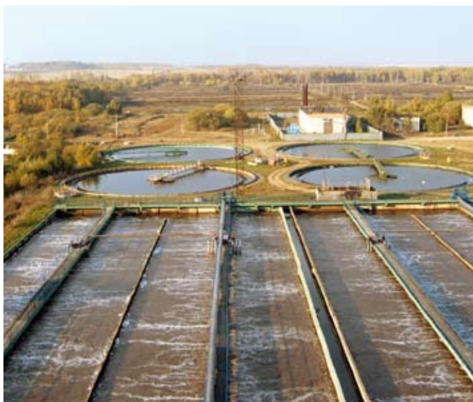
Общий вид сооружений по очистке сточных вод
