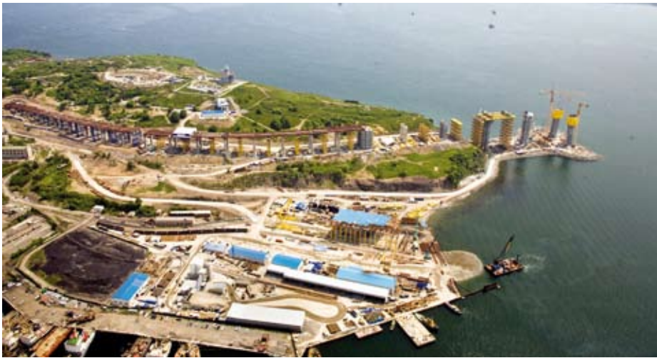
Строительство объектов саммита АТЭС во Владивостоке с высоты птичьего полета
