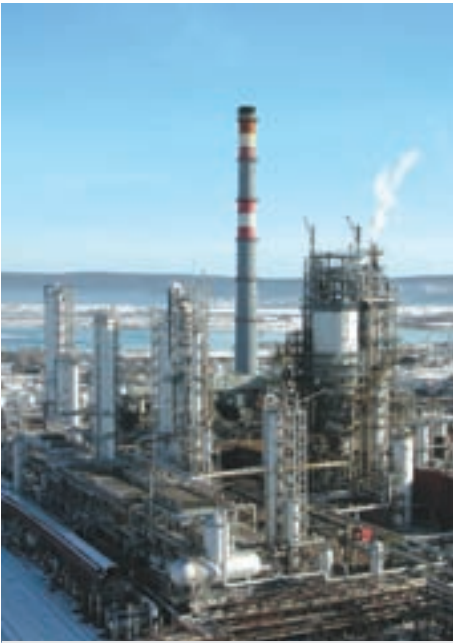
Ангарский нефтеперерабатывающий завод
