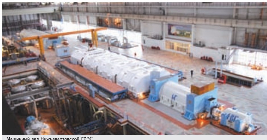
Машинный зал Нижневартовской ГРЭС
