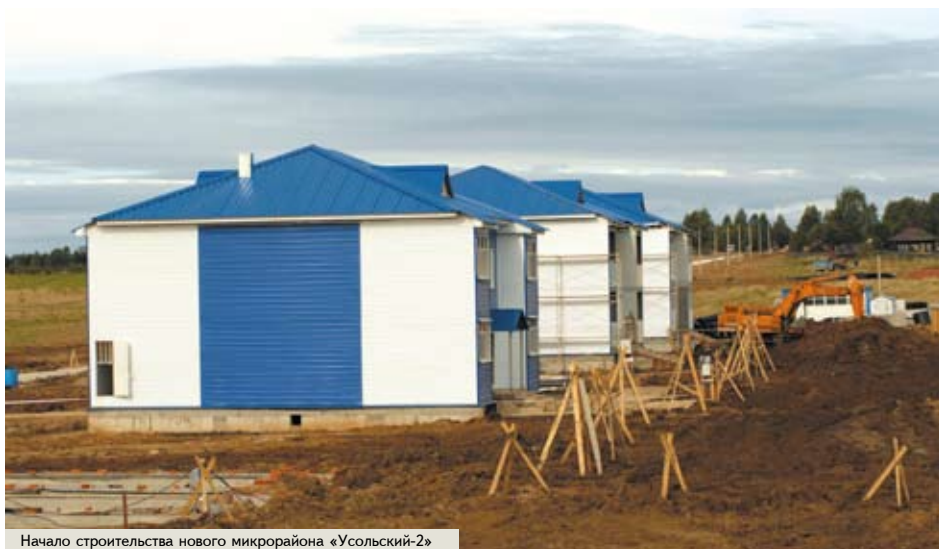
Начало строительства нового микрорайона «Усольский-2»
