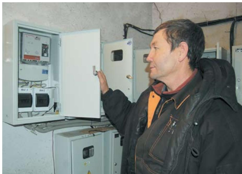
Центральное устройство сбора, хранения и передачи информации — концентратор — устанавливается в трансформаторной подстанции
