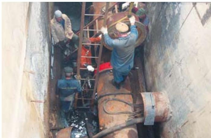
Работники ООО «Водоканал-НТ» меняют затворы трубопровода
