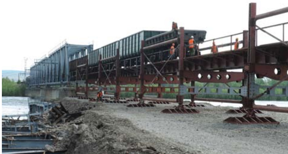
Восстановление моста через реку Абакан
