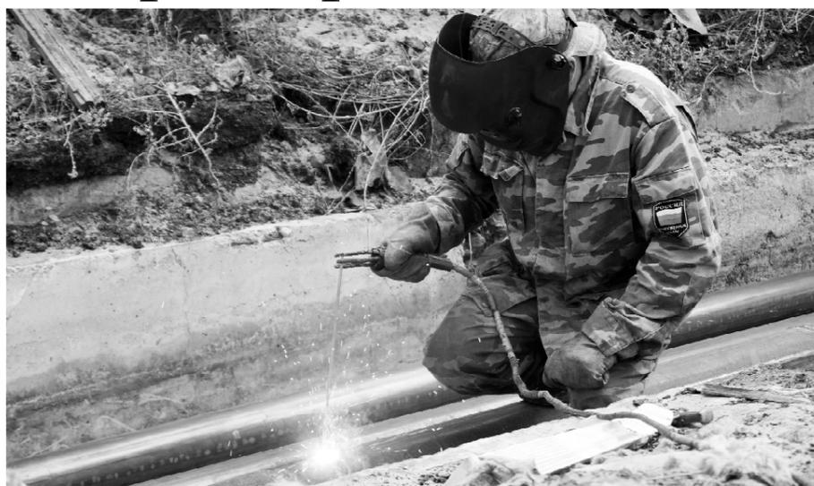
Проводится сварка труб на тепловой трассе около котельной.
