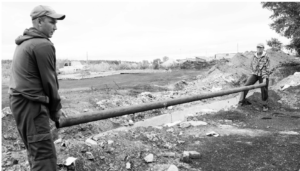
Новые трубы занимают свое место в теплопроводе.
