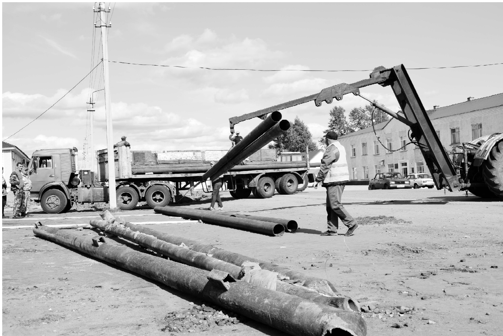
Старые трубы теплотрассы уже извлечены, идет выгрузка новых.
