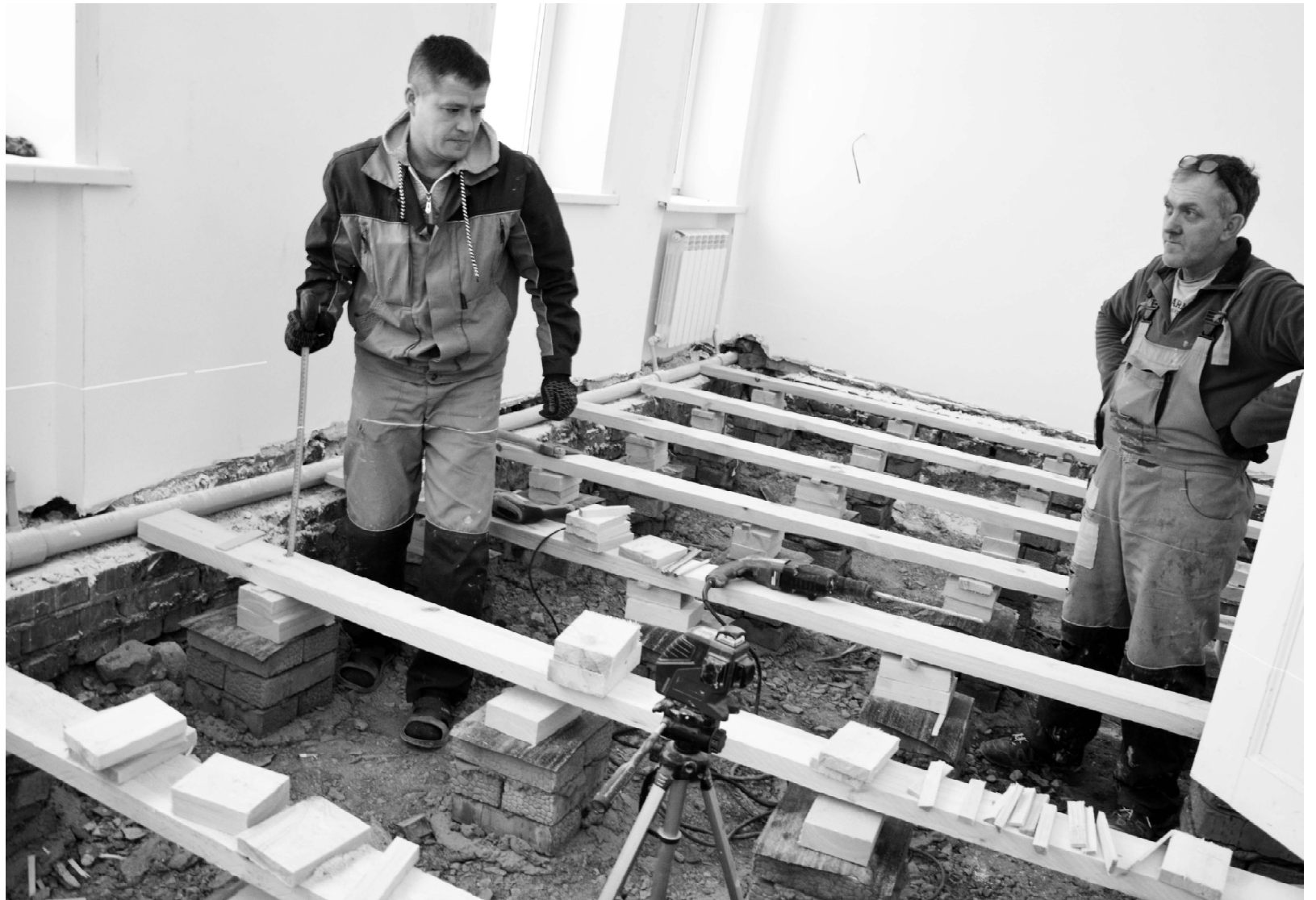
В палатах стационара ведут строительство деревянных полов.
