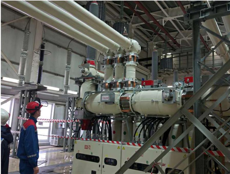
На Усть-Среднеканской ГЭС имени А.Ф. Дьякова на реке Колыма в Магаданской области завершён монтаж и высоковольтные испытания второй очереди комплектного распределительного устройства напряжением 220 кВ. Новая
