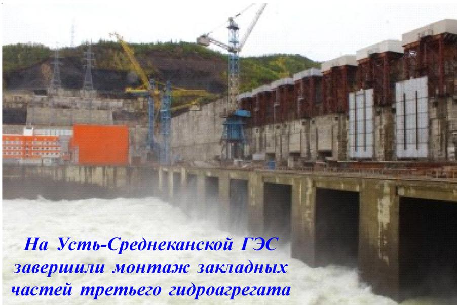
**На Усть-Среднеканской ГЭС завершили монтаж закладных частей третьего гидроагрегата**
