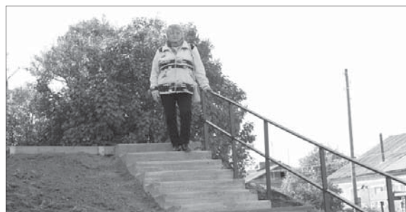
Вот такую лестницу соорудили для жителей дома №11 по ул. Строителей.
