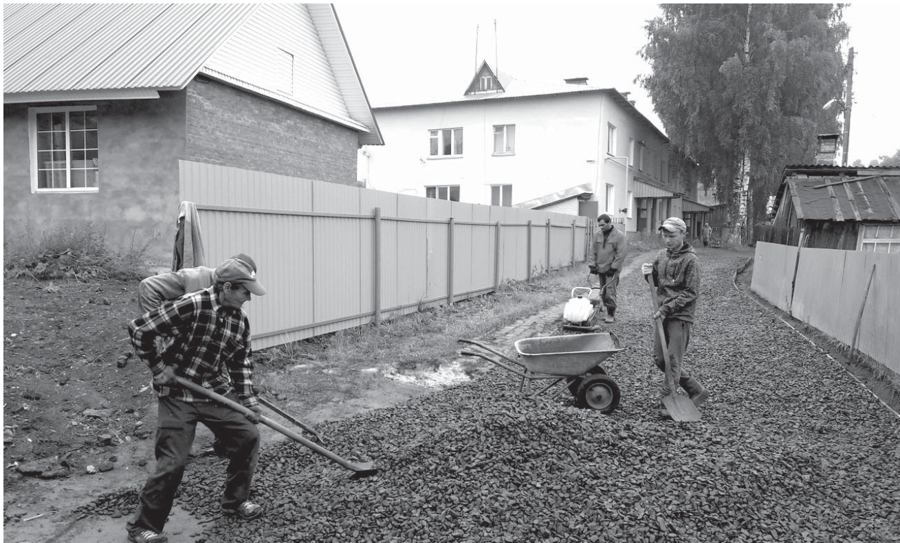
Идет ремонт дороги к дому Первомайская, 20 с. Юкаменское.
